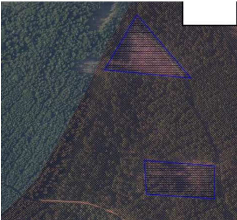
Abbildung 21: Lage der Maßnahmen E8 – Teilflächen Waldhaus SM64a4 und Waldhaus SM65a5. Waldumbau Stadtwald Schmalkalden (Flurstück 33 in der Flur 1 der Gemarkung Schmalkalden). Luftbild: Stadt Schmalkalden 2025)
