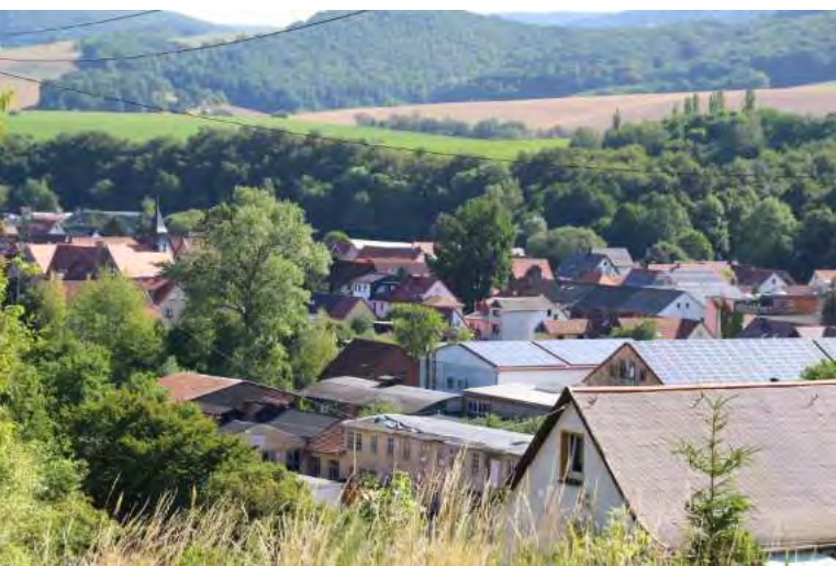
Abb. 48 Dachlandschaft von Schmalkalden mit Photovoltaikanlagen
