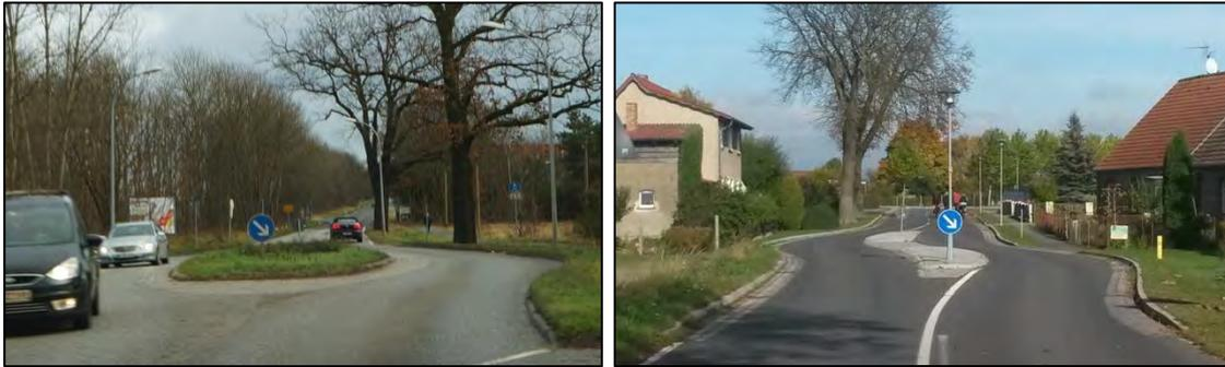
**Abb. 26** Beispiele Ortseingangsgestaltung mit Fahrstreifenversatz
