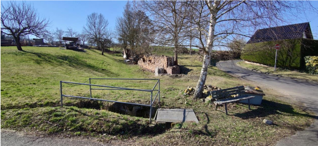
Abbildung 9 Ansicht der Straße Möckerser Berg am Abzweig zum Friedhof nach Westen
